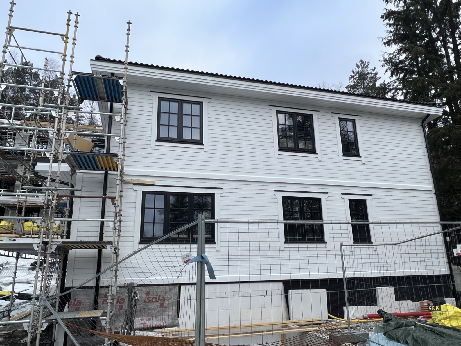
Bilde fra byggeplassen
