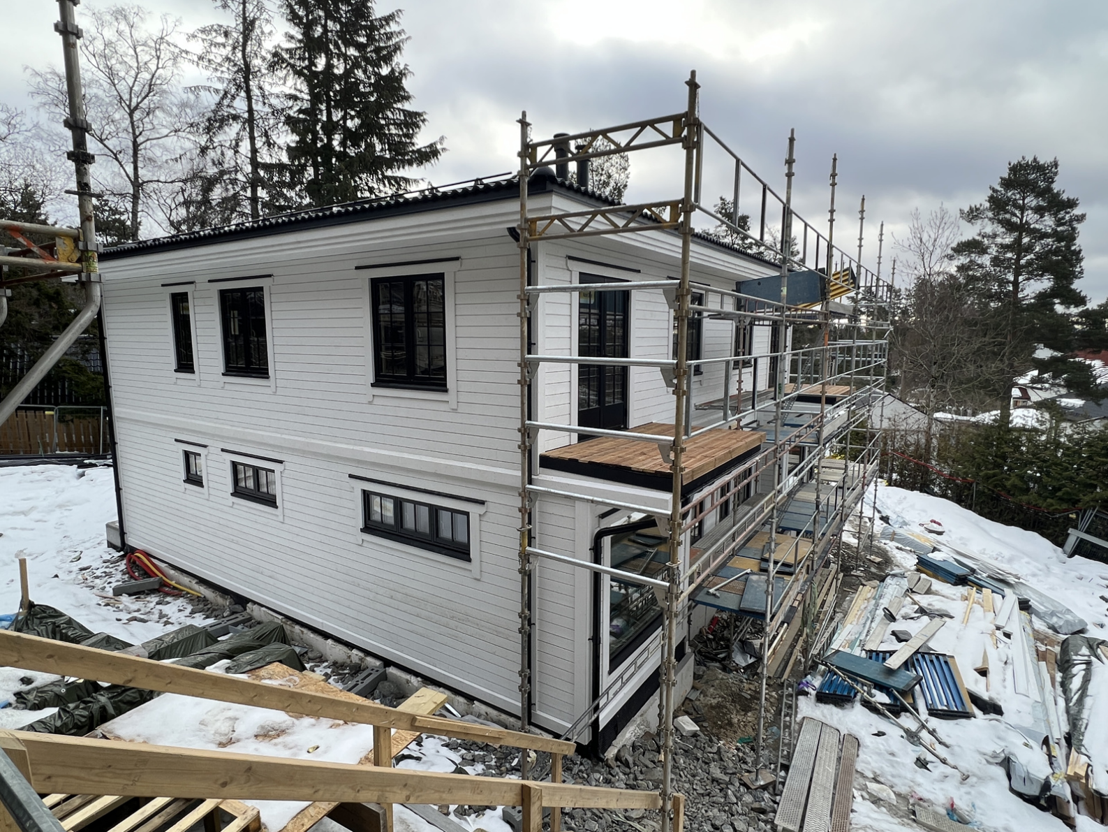
Bilde fra byggeplassen
